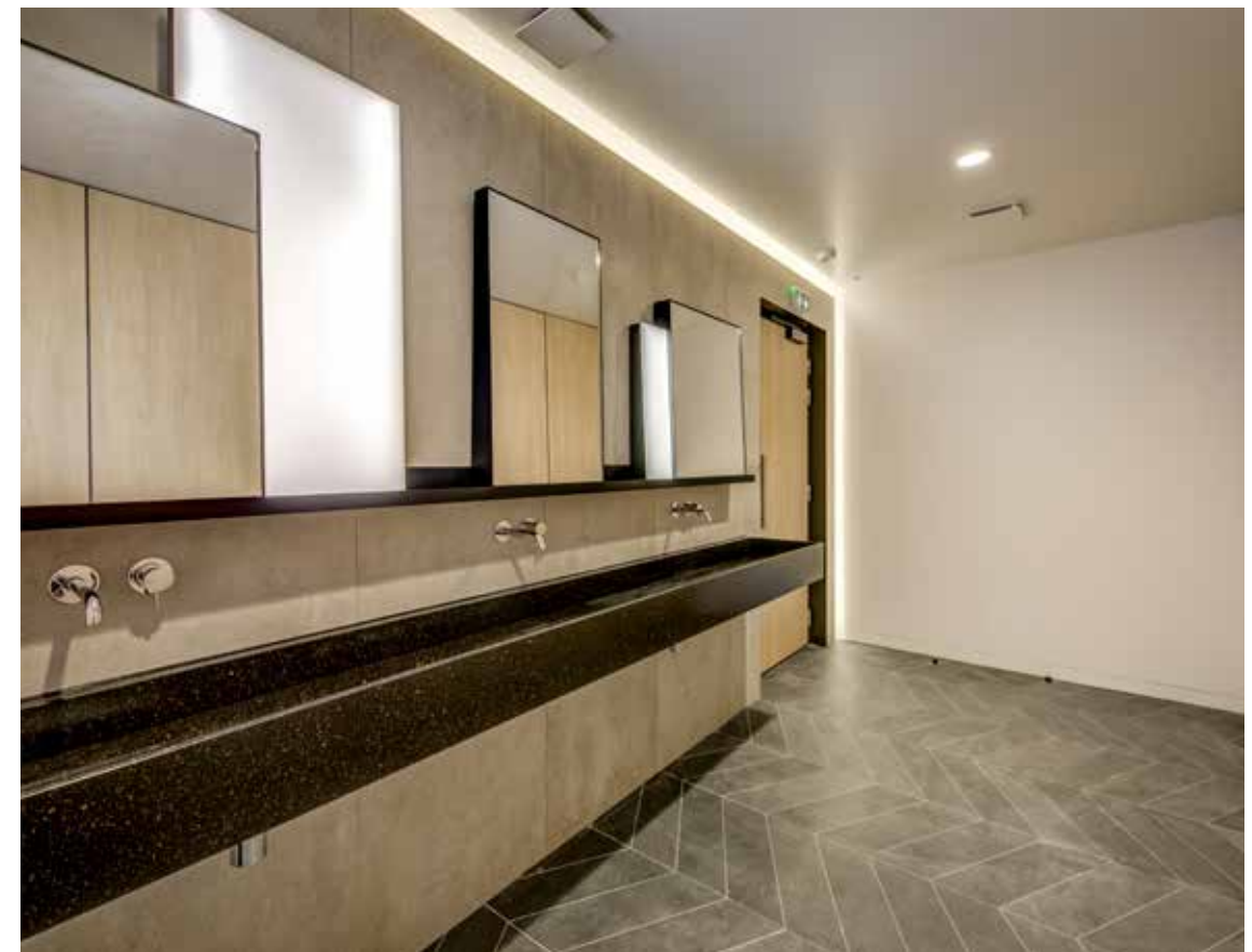
↑ Sanitaires hors-site, bâtiment Alten, Campus Now Living Spaces, Toulouse (33)
