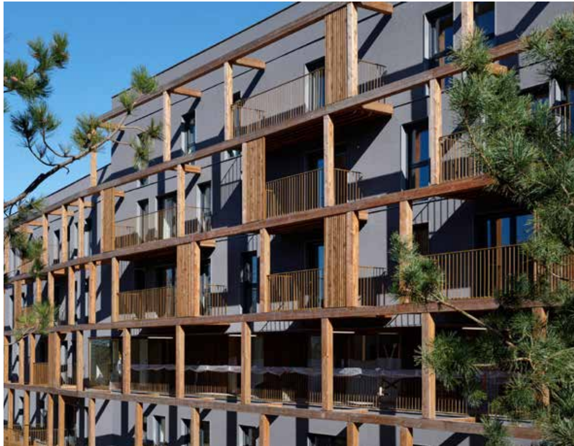
↑ Ensemble de 2 bâtiments de logements, Torcy (77) - A+ / Samuel Delmas
