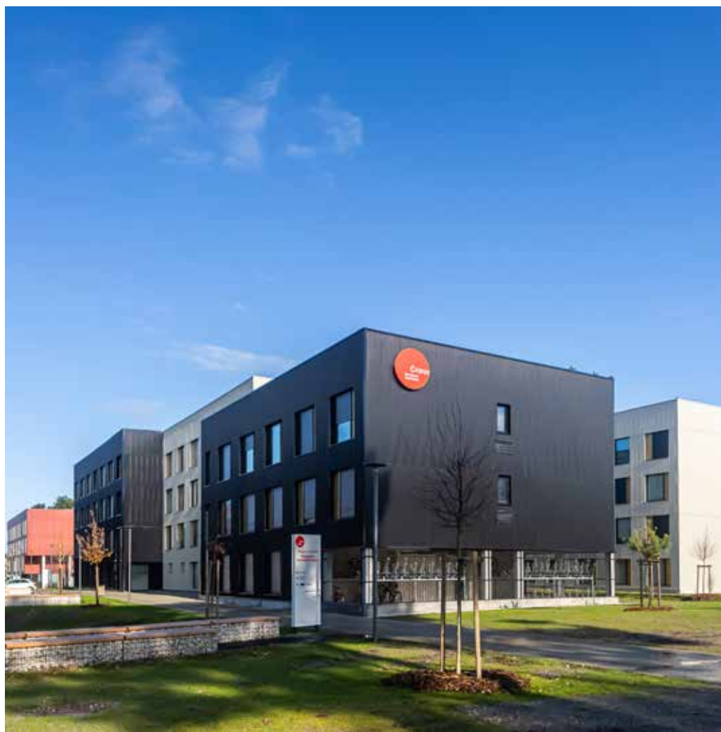
↑ CROUS Pessac, résidence étudiante en modulaire bois (33) - Flint Architectes
