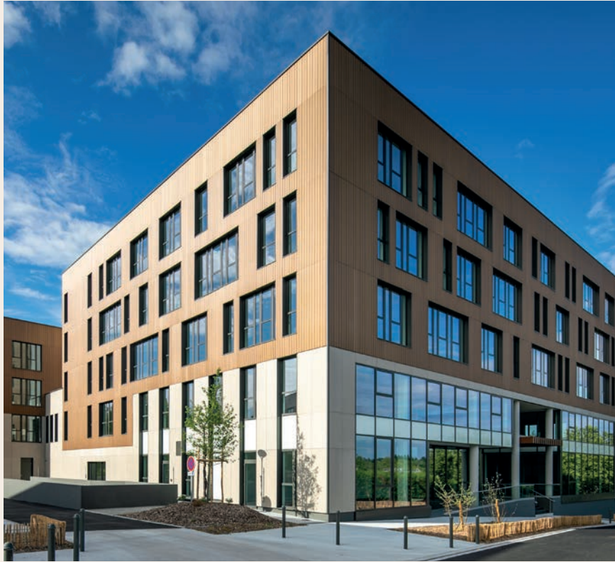
Immeuble de bureaux - EKNOW - Nantes (44) - CLAD 14 - Teinte Sun • Architecte : A26 Architectures
