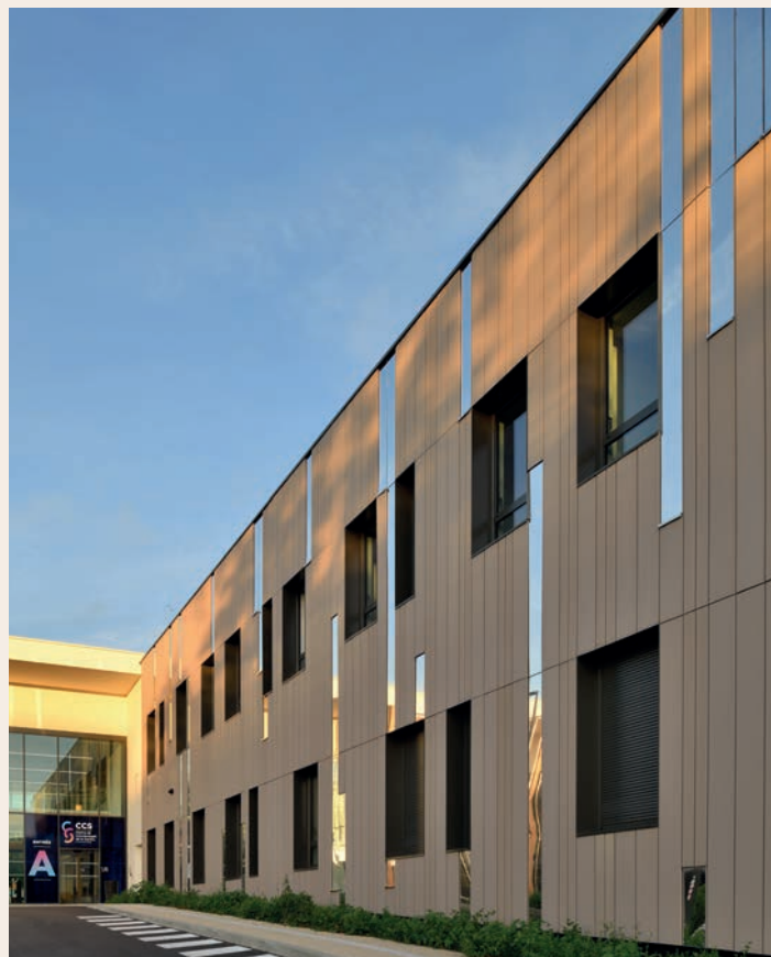
Centre de cancérologie - Le Mans (72) - COVER 14 & 30 - Teinte Sand • Architecte : Chabanne • © Crédit photo : Erick Saillet
