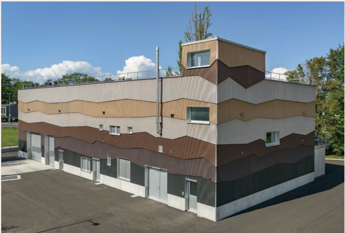
STEP - Thonex, Suisse - CLAD 4 - Teintes Graphite, Earth, Heat, Sand & Sun • Architecte : DZ Architectes • © Crédit photo : Didier Jordan
