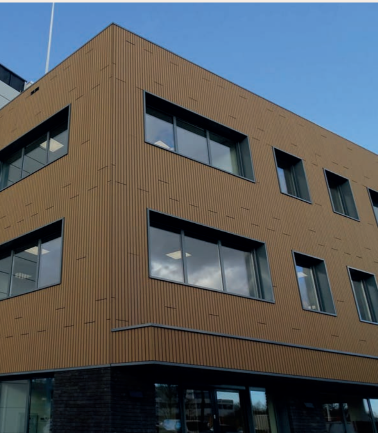
Siège Social Maasdelta Groep - Pays-Bas - COVER 6 - Teinte Sun • Architecte : Groosman Architecten
