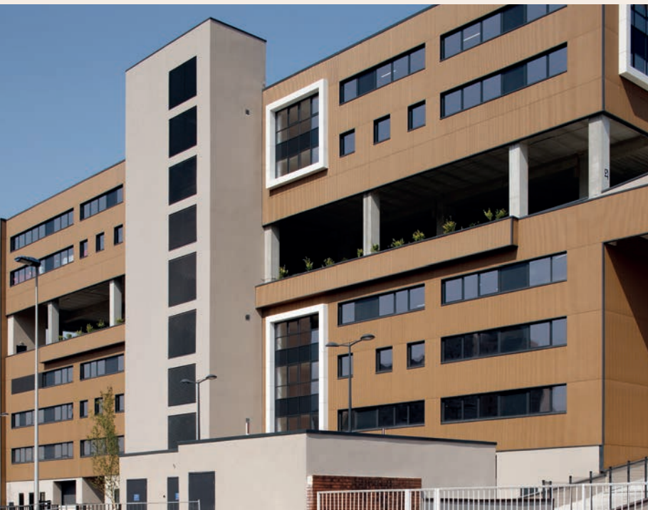
EcoCity Parc - Colombes (92) - CLAD 4 - Teinte SUN • Architecte : MW Architecture • © Crédit photo : Daniel Moulinet
