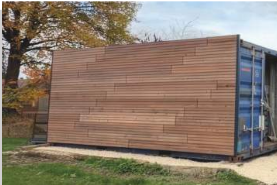
Après la pose
