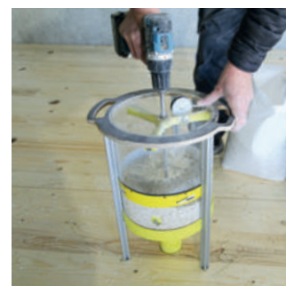
À l'aide d'une visseuse sans fil, introduire le granulé de remplissage à faible vitesse dans la CLT BOX – DALLE FS
