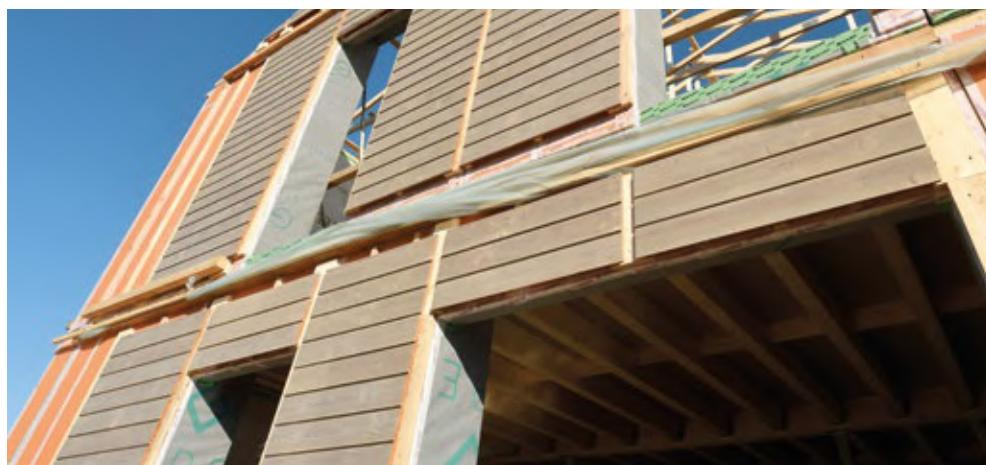
La fixation des plaques se fait par agrafes, vis ou clous, avec un entraxe de fixation maximal de 150 mm sur le pourtour de la plaque et de 300 mm sur les ossatures en milieu de plaque.
