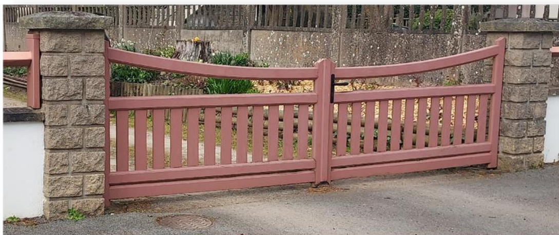
Portail Liffré en Sipo - Cintré - Finition couleur
