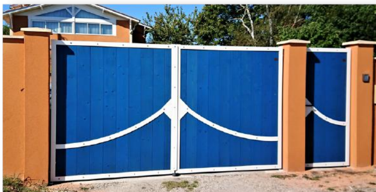
Portail SW204 en épicea T.H.T. - thermolaquage du cadre acier et finition couleur Pose réalisée par Tendence fenêtres (Mazère, dpt 33)
