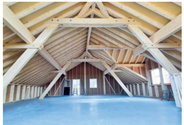
Charpente visible de maison individuelle, Rothenburg (CH)
