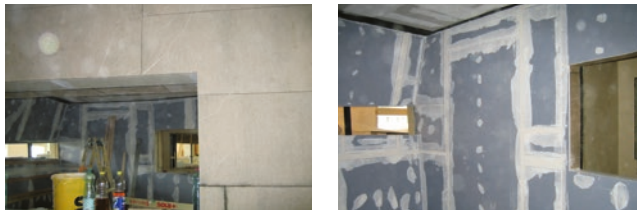
Aménagement d'une maison de radio avec des feuilles lourdes Idikell®
