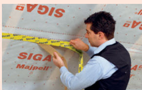
Recouvrements sur un frein-vapeur
