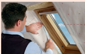
Raccordement d'une fenêtre de toit
