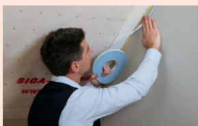
Pare vapeur sur mur maçonné
