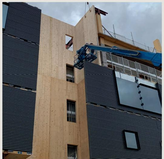
Progettazione MockUp e fornitura di tutti gli elementi lignei in legno lamellare e pannelli XLAM per elementi pareti e solai.
