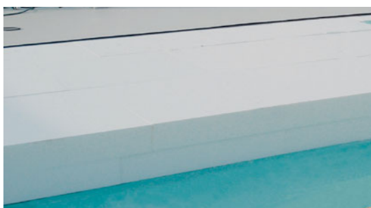
Pose libre de deux lits de panneaux Knauf Therm TTI Se sous revêtement synthétique indépendant
