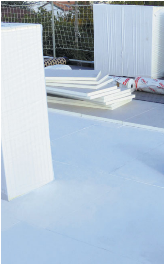
Sur le pare vapeur, pose libre du 1 er lit de panneaux isolants Knauf Therm TTI Se puis pose libre à joints décalés du 2 ème lit de panneaux isolants Knauf AsfalThane.
