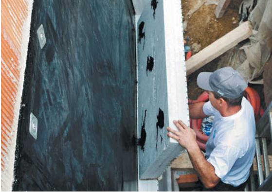
Collage des panneaux de Knauf Perimaxx Resist sur le support, de bas en haut
