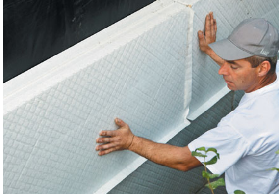
Emboîtement et serrage des panneaux de Knauf Perimaxx Resist entre eux
