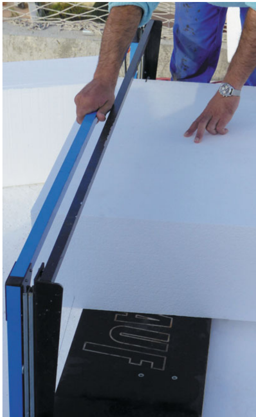
Découpe au fil chaud des panneaux isolants Knauf Therm TTI SE.
