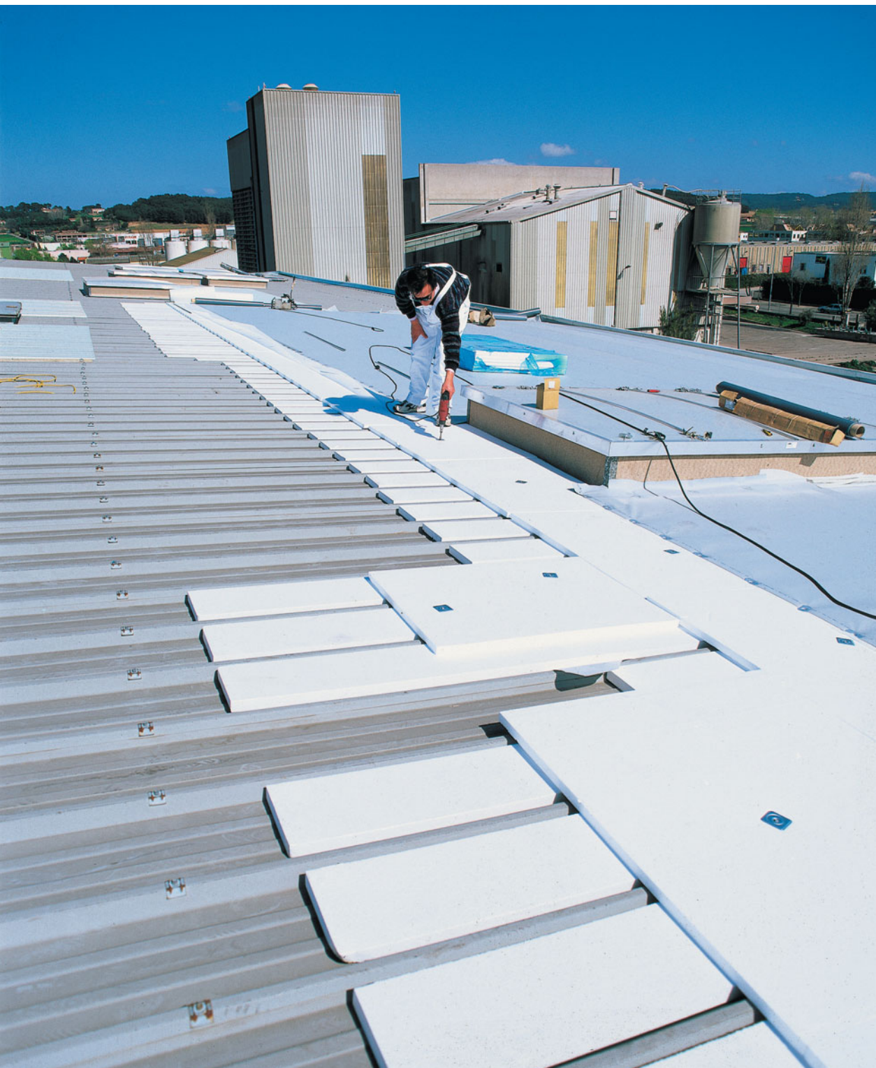
Mise en œuvre du procédé Knauf Therm Renovtoit BA 2 support de revêtement d'étanchéité fixé mécaniquement
