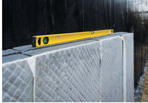
Collage des panneaux Knauf Perimaxx ULTRA sur le revêtement d'étanchéité, à partir du sol
