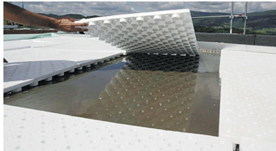
Pose des plaques de drainage Knauf Hysoldrain sur le revêtement d'étanchéité
