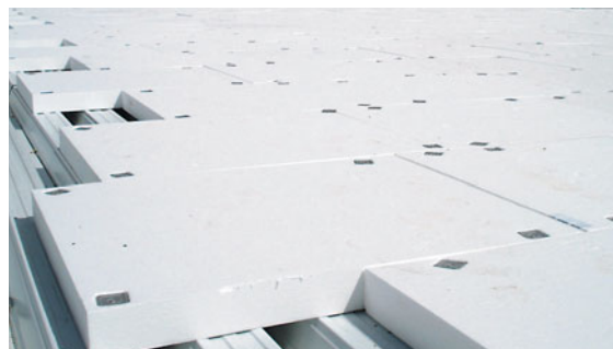
Telecify Group Centre informatique à Aubervilliers (93) - Entreprise GUINDE - Pleudihen sur Rance 6 600 m 2 de Knauf Therm TTI Se ép. 100 mm sur bac acier "grande portée"
