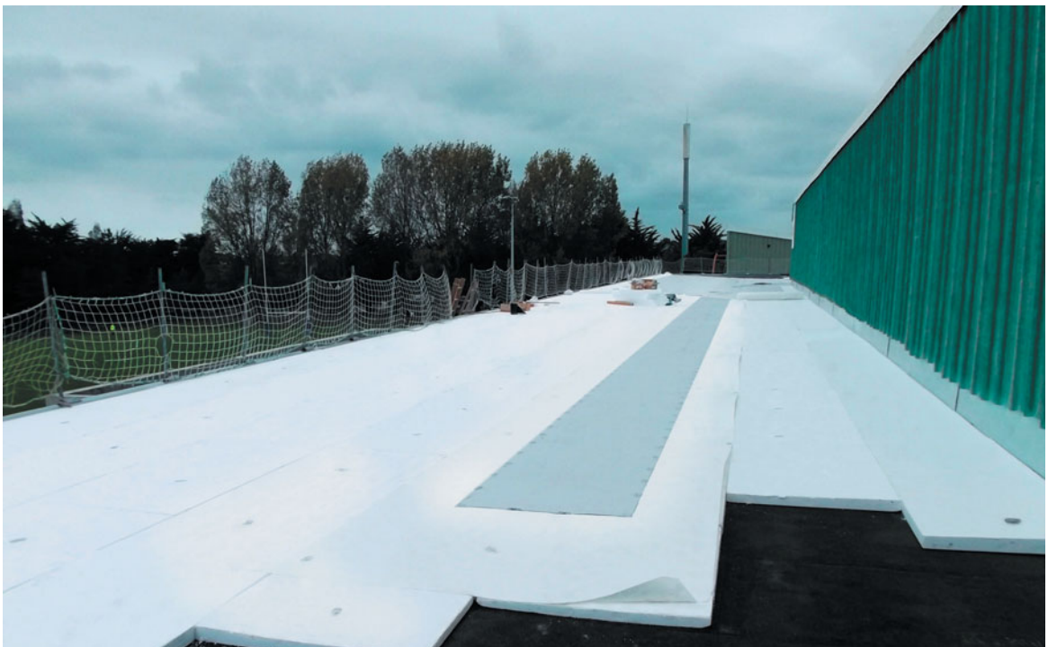
Rénovation d'une toiture isolée en tôle d'acier nervurée : mise en œuvre des panneaux Knauf Therm TTI Penté Se sous revêtement d'étanchéité fixé mécaniquement
