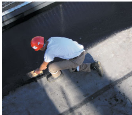
Mise en œuvre d'asphalte mixte sur le procédé Knauf AsfalThane
