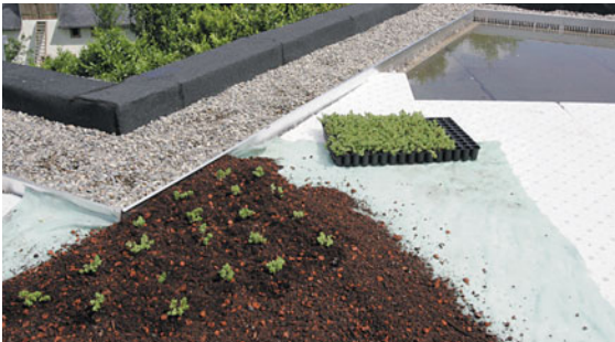
Toiture végétalisée extensive : pose du géotextile, du substrat et des sédums
