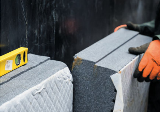
Emboîtement entre les feuillures des panneaux, à joints serrés
