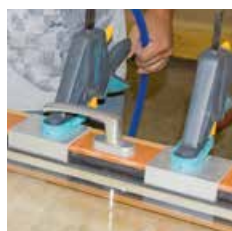
Presser la vitre contre les joints extérieurs
