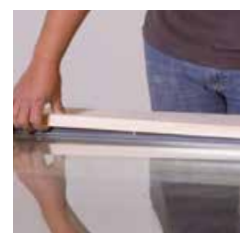
Clipser la parclole sur FIXclip-Barre
