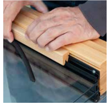
Mise sous pression avec le joint à bourrer
