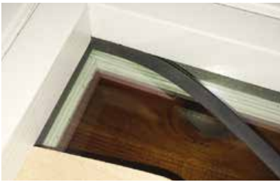
Exemple de montage : Bourrage du joint
