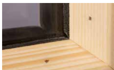
Fixation traditionnelle de parclose par clouage.
