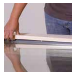
Clipser la parclose sur FIXclip-Barre
