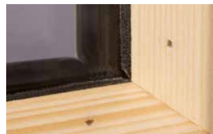
Fixation traditionnelle de parclose par clouage.
