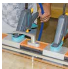
Presser la vitre contre les joints extérieurs
