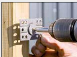
Vissez bien la ferrure pour clôture en treillis à l'aide d'une vis pour clôture en treillis de face sur la surface de clôture. Nous recommandons au moins 2 ferrures par côté, donc 4 ferrures par élément de clôture en treillis
