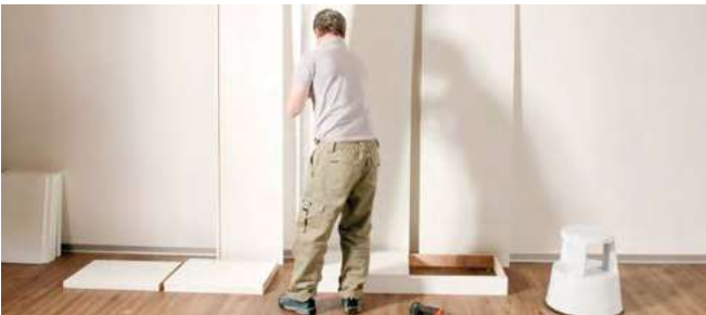
Placer le côté du meuble sur le socle. L'élément est directement positionné correctement grâce à la vis saillante.
