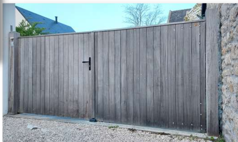
Portail Bois Plage en Sipo, après deux ans d'exposition Alain Le Lamer (dpt 56)
